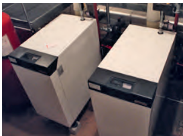
Oben: Die beiden Weishaupt-WTC-GB-250-Gas-Brennwertkessel im Kloster Wil, rechts der Plattenwärmetauscher.
