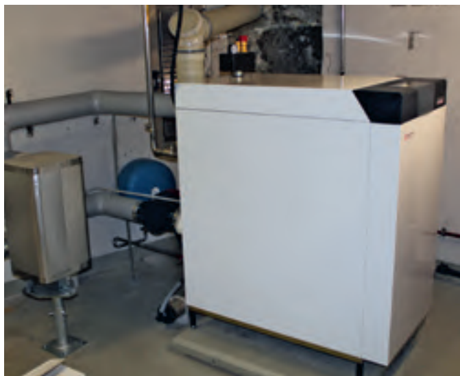
Der Weishaupt-WTC-GB-210-Gas-Brennwertkessel im Schloss Wartensee, links hinten der Plattentauscher der Systemtrennung.
