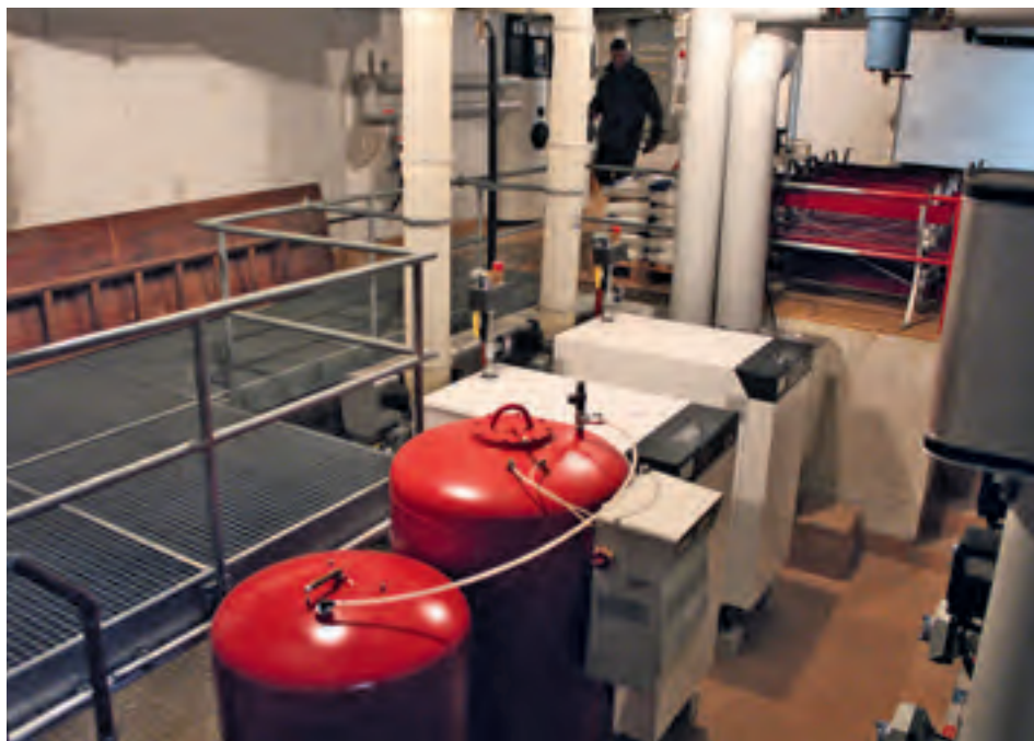
Oben: Die beiden Weishaupt-WTC-GB-250-Gas-Brennwertkessel im Kloster Wil, rechts der Plattenwärmetauscher.
