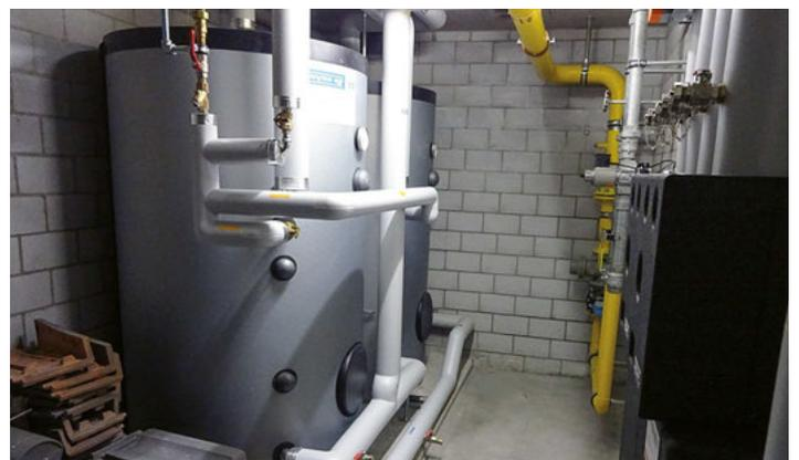
Die beiden 600-l-Boiler und rechts die Modulverteiler-Elemente von Weishaupt in einer der Unterstationen.
