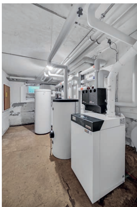
Der Öl-Brennwertkessel, dahinter Energie- und Trinkwasserspeicher
