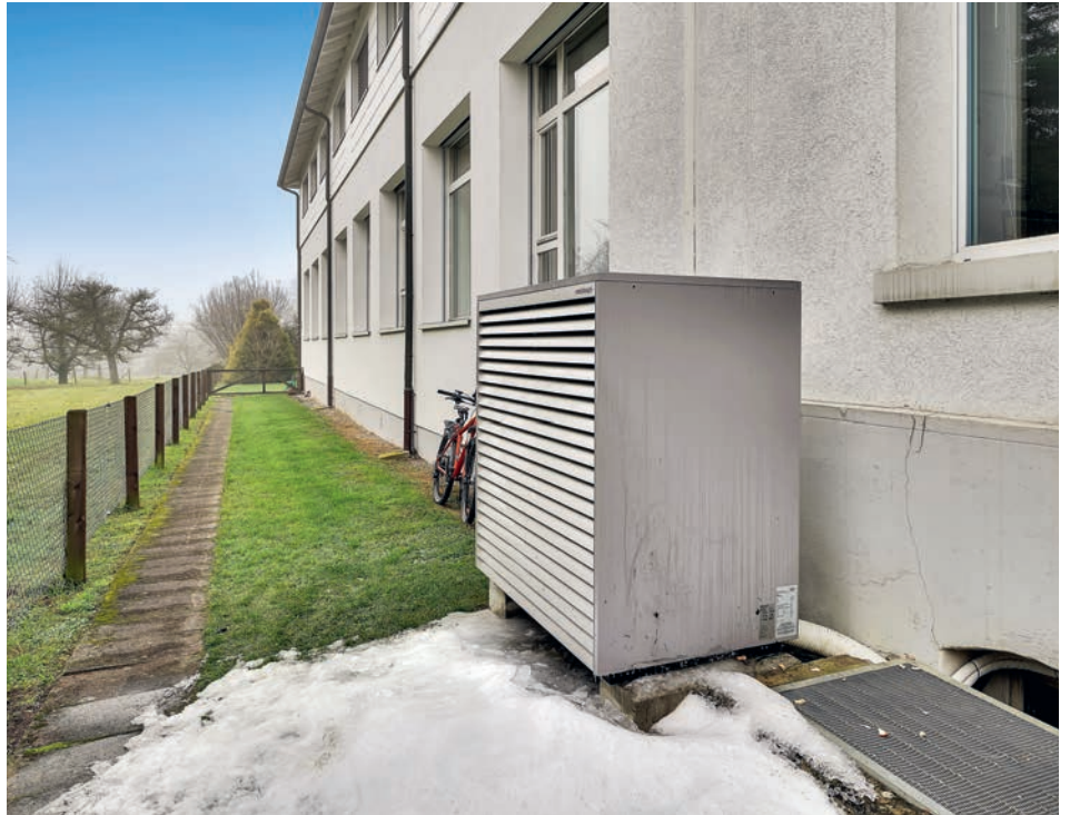
Das leise Aussengerät der Weishaupt-Biblock-Wärmepumpe
