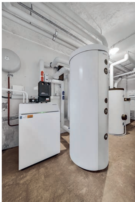
Links das Innengerät der Wärmepumpe mit Kompressor, davor der Trinkwasserspeicher, hinten Energiespeicher und Ölkessel
