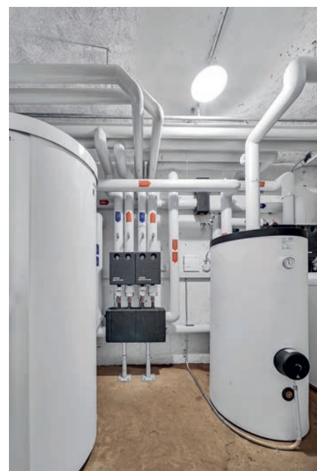
Die beiden Weishaupt-Speicher, dahinter ein Teil der Verteilung
